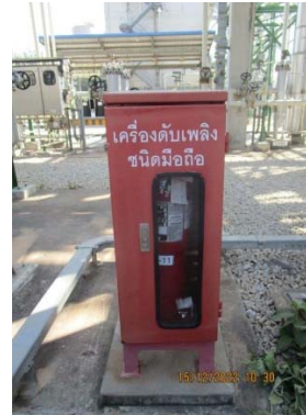
รูปที่ 48 Portable Fire Extinguishers
