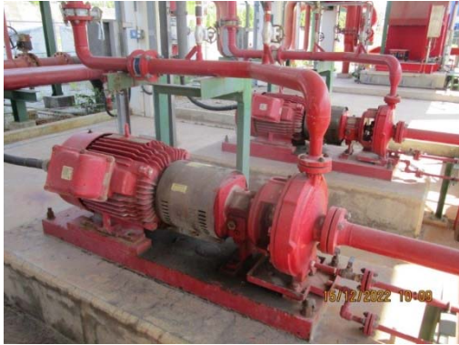
รูปที่ 59 Electric Jockey Pump
