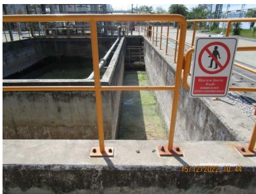
รูปที่ 9 Oil Separator
