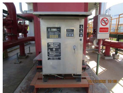
รูปที่ 57 Diesel Fire Pump
