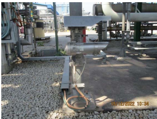
รูปที่ 51 Flame Detector
