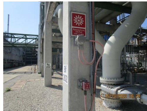
รูปที่ 50 Manual Pull Station
