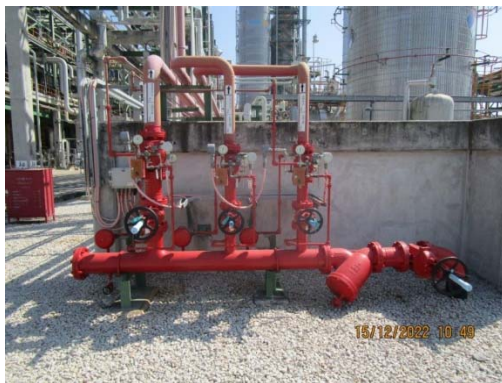
รูปที่ 43 ระบบน้ำดับเพลิงระบบเปิด (Deluge Water Systems)
