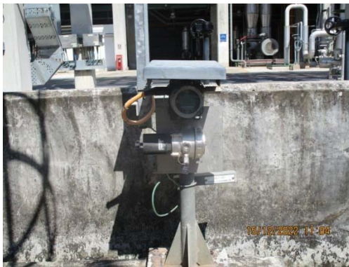
รูปที่ 49 Gas Detector
