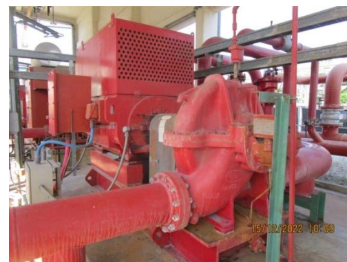
รูปที่ 58 Electric Fire Pump
