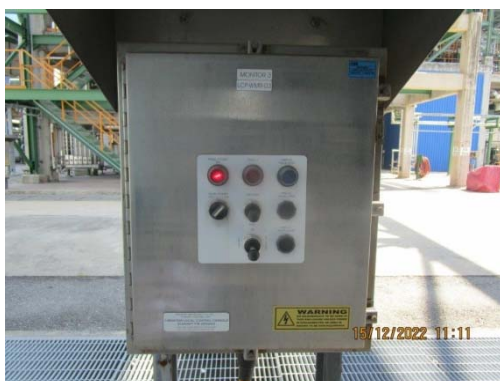
รูปที่ 45 Water Monitor Remote
