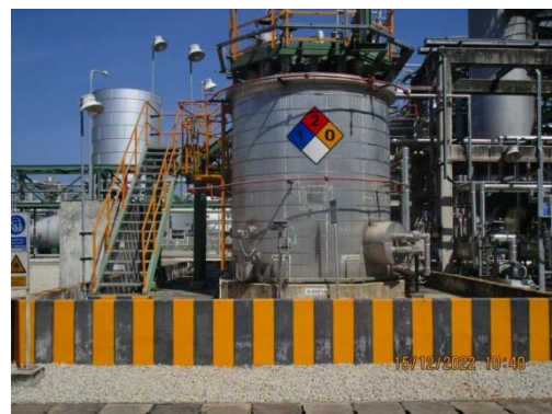
รูปที่ 34 คั่นคอนกรีตรอบถังเก็บ
