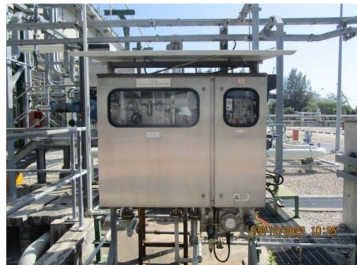
รูปที่ 16 Conductivity Online บริเวณท่อส่งกลับน้ำหล่อเย็น
