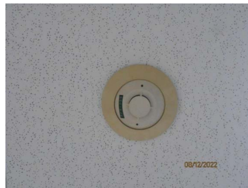
รูปที่ 52 Smoke/ Heat Detector
