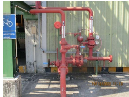
รูปที่ 42 Wet Alarm System
